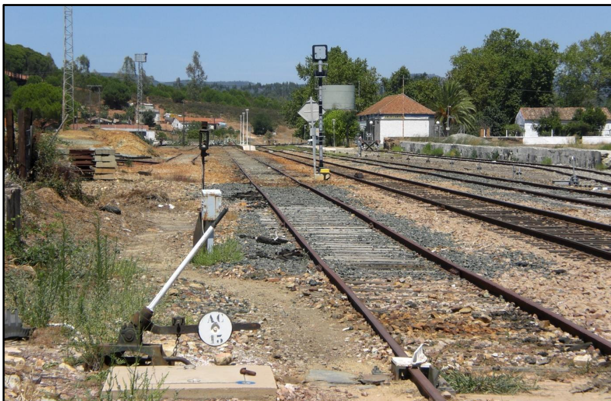
Línea de ferrocarril Zafra-Huelva a su paso por Valdelamusa.
